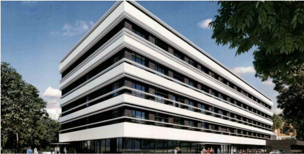
Le futur site de la Salette Montval accueillera chemin Joseph Aiguier, dans le 9 e , un hôpital de soins de suite et de réadaptation et une unité de soins longue durée d'un peu plus de 6000 m 2 dans lequel il y aura 120 lits. © Saint Joseph
